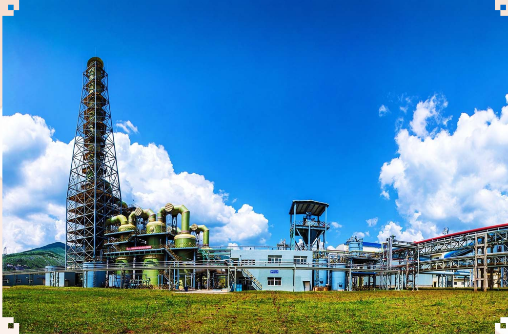
图为会泽冶炼尾气脱硫塔。
