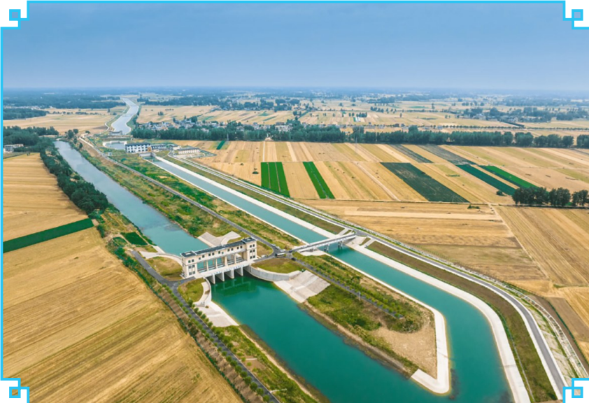
图为重大节水供水工程之一的引江济淮工程(河南段)。 图片来自《河南日报》
