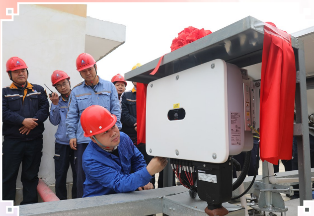
图为广西华磊启动光伏项目。
